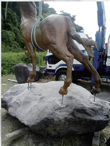
蹄から垂直にステンレスポルトを差し込む
