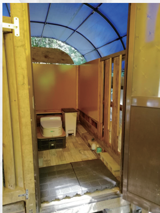
中古のアルミ製ドアを取り付ける。
