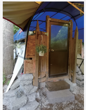
外観。入口は三段の石製階段にした。テントと便器以外はありあわせの材料でまかなった。
